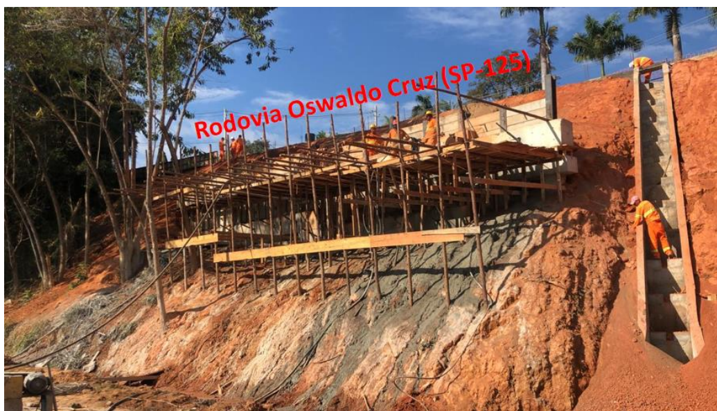
Figura 19 - Andaime montado e instalado no talude a ser contido por muro de concreto e tirantes.
