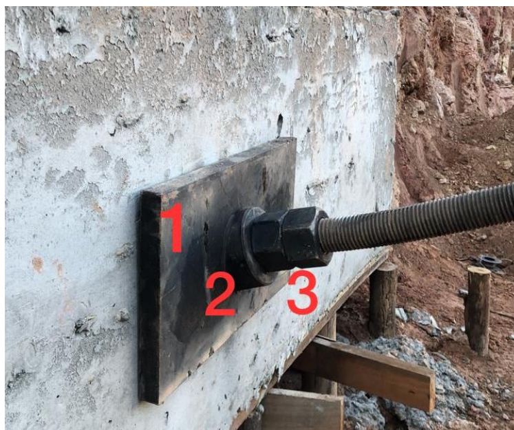
Figura 7 - Elementos da cabeça de tirante monobarra: (1) Placa de apoio, (2) Cunha de grau, (3) Bloco de ancoragem contendo porca e contra porca. Foto tirada em Varginha a serviço da CAP ENGENHARIA E GEOTECNIA.
