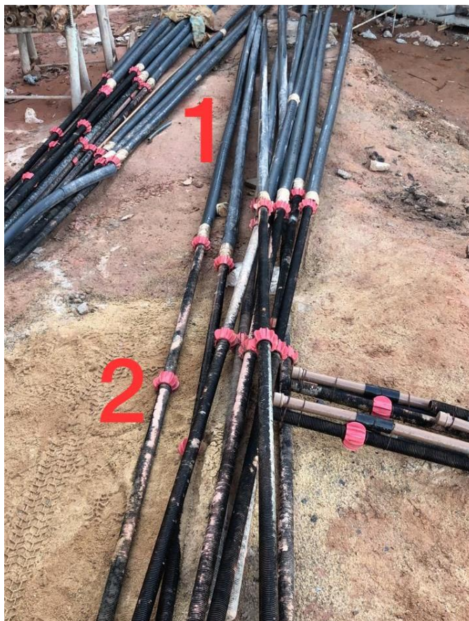
Figura 8 - Montagem de tirantes contendo: (1) Trecho livre protegido por mangueira, (2) Trecho ancorado contendo espaçadores de plástico. Foto tirada em Varginha a serviço da CAP ENGENHARIA E GEOCTENIA.
