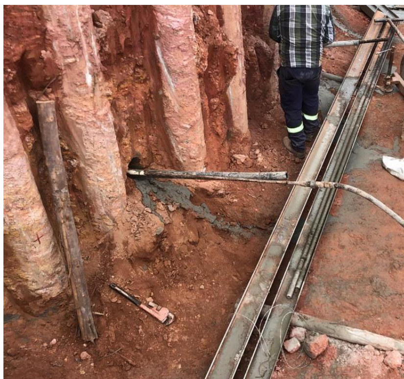
Figura 12 - Injeção do primeiro estágio com vazamento pela boca do furo. Foto tirada em Varginha a serviço da CAP ENGENHARIA E GEOTECNIA.
