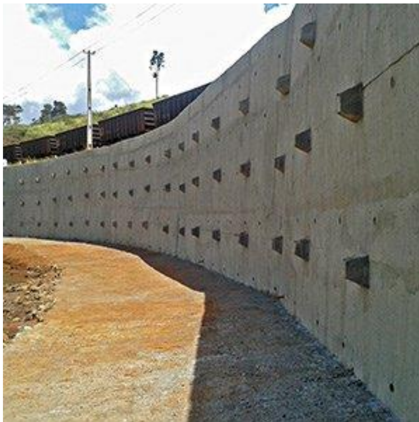
Figura 13 - Modelo de cortina atirantada. Extraído de Solotrat ( http://www.solotrat.com.br/cortinas-atirantadas ).
