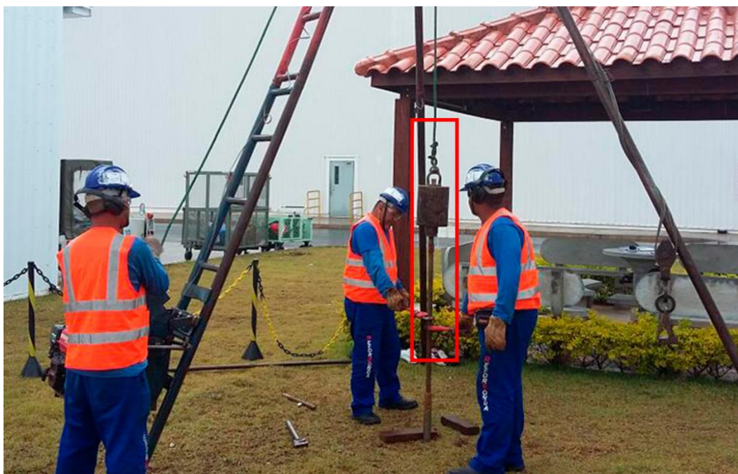
Figura 2 - Execução de sondagem à percussão com destaque para martelo de 65kg no centro. Extraído de: https://reforsonda.com.br/o-criterio-de-paralisacao-das-sondagens-a-percussao-spt/
